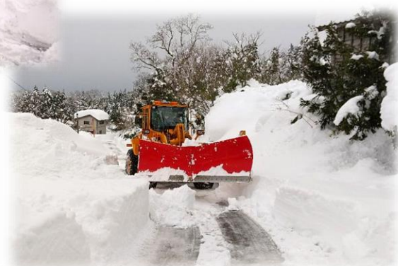
除雪作業の状況
