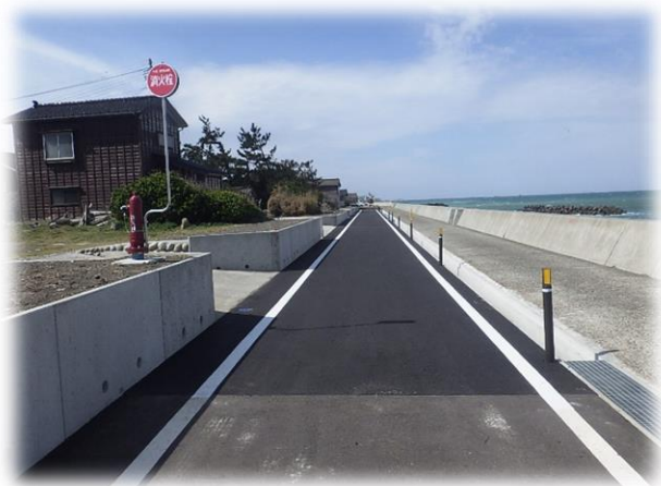
新設された市道大和川海浜線
